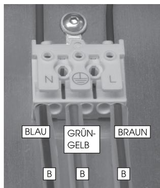
Links befindet sich der Nullleiter (N), blaues Kabel. In der Mitte befindet sich die Erdung, grün-gelbes Kabel. Rechts befindet sich die Phase (L), braunes oder schwarzes Kabel.
