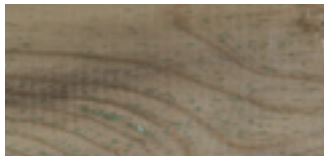
Raue Stellen auf der Holzoberfläche
